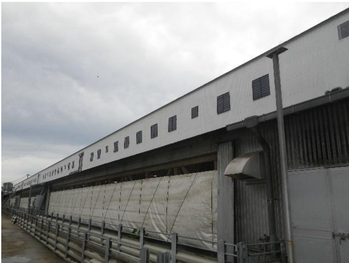
肥育舎脱臭システム導入後
