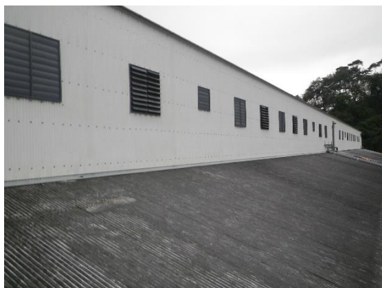
肥育舎脱臭システム導入後
