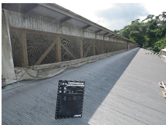
肥育舎脱臭システム導入前
